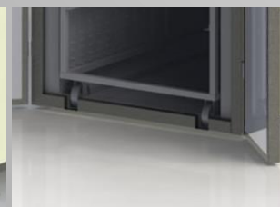
Rails de roulement dans le sol
